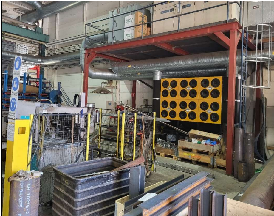
Figur 13. Plymoventfilter av typen Multidust Bank MDB-24.
